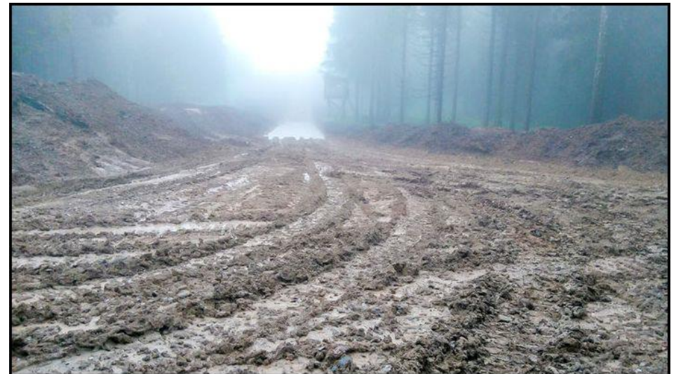
WEA- Baustelle im Wald bei Gersbach / Schopfheim
